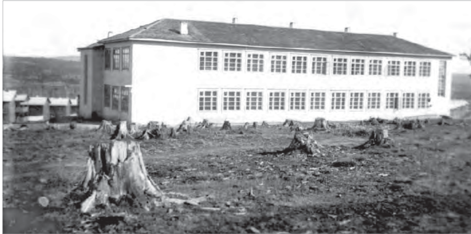
Здание школы, построенное в середине 30-х годов. Сейчас - район домов №22 и 24 по улице Пушкина.
