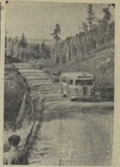
Иркутская область. В районе строительства Братской ГЭС ведутся большие работы по сооружению подъездных путей, строительству жилья.
