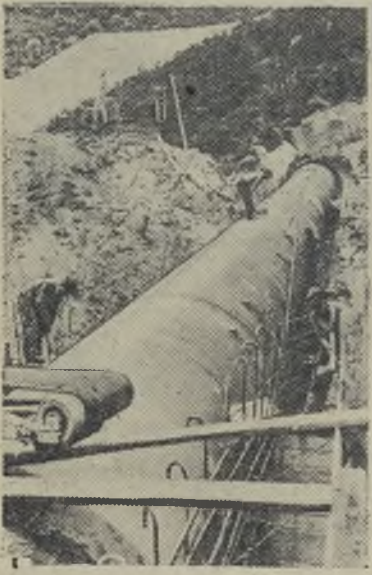
Грузинская ССР. Строительство Ткибули ГЭС вступило в предпусковой период. Закончено сооружение 2500-метрового туннеля, по которому пойдут воды реки Ткибули.
