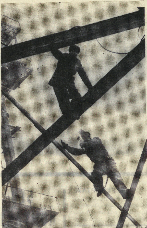
Порой, как цирковые артисты, монтажники Уралстальконструкции монтируют сложные металлоконструкции.
