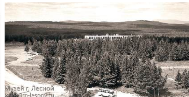
Школа № 75 только построена, 1971 год (фото С.Федоровского).
