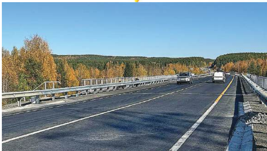
Ремонт путепровода региональной трассы в районе Нижнего Тагила завершён.
