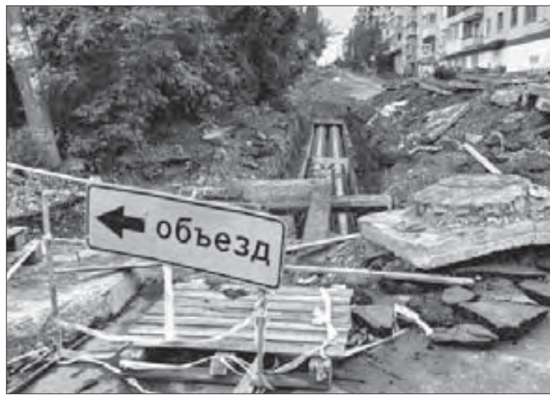
На улице Матросова в этом году проводится капитальный ремонт тепловой сети протяжённостью более 2 километров
