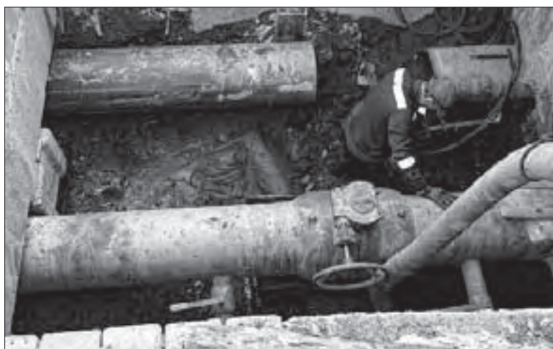
Один из самых больших отремонтированных участков в южной части города – в районе улицы Бажова – заменено 20 метров трубы
