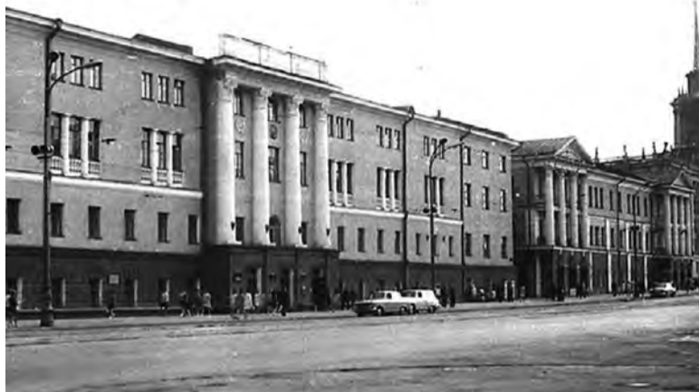
В учебных аудиториях Свердловского горно-металлургического техникума во время войны размещались эвакуационные госпитали
