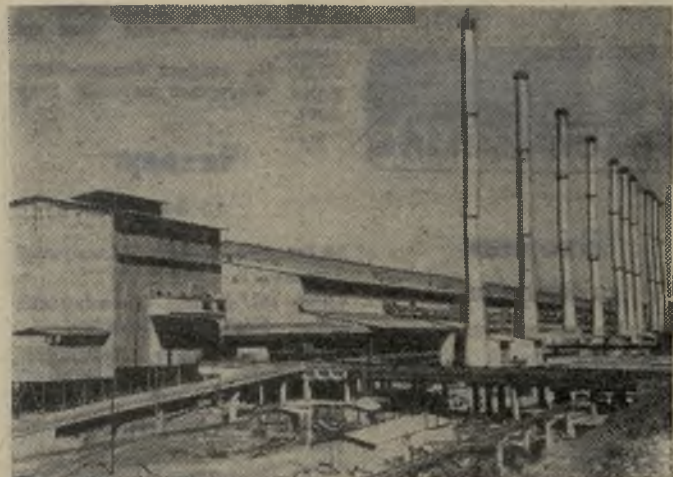
ИНДИЯ. Мартеновский цех Бхилайского металлургического завода, построенного с помощью Советского Союза. Фотохроника ТАСС
