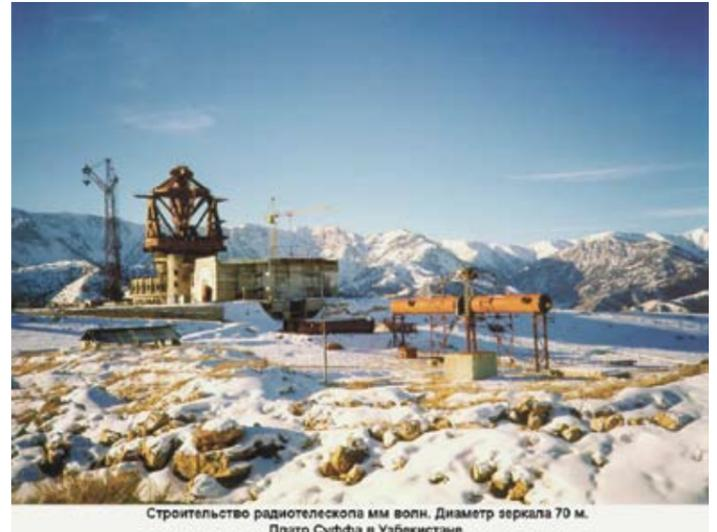
Строительство радиотелескопа мм волн. Диаметр зеркала 70 м. Плато Суффа в Узбекистане.
