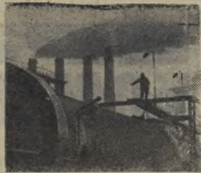
г. Михайловка (Волгоградская область). На снимке — фрагмент Себряковского цементного завода имени П. А. Юдина.
