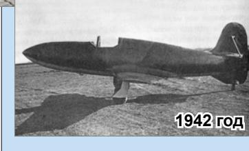
Самолёт БИ-1 (Березняк и Исаев) — экспериментальный истребитель-перехватчик с жидкостным ракетным двигателем. Самолёт с цельнодеревянным корпусом имел необычно малые размеры: размах крыла 6,48 м, длину 6,4 м. Скорость максимальная — около 800 км/ч. Вооружение: две пушки с 90 снарядами и 38 кг бомб. Была построена войсковая серия в восемь самолетов. Опыт немногочисленных полётов показал, что самолёт БИ как истребитель принят быть не может из-за чрезмерно малой продолжительности полёта.
