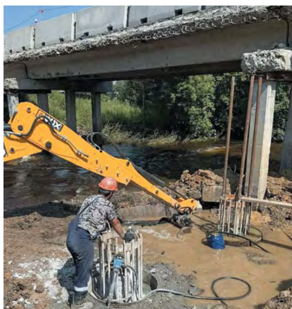
Масштабный ремонт моста через реку Кунару в д. Мельничной / ФОТО ИЗ АРХИВА ПАВЛА МАКАРОВА
