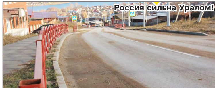
Дорога по переулку Школьному сдана в 2024 году
