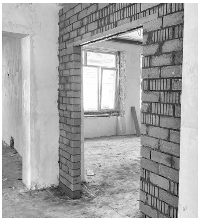
Новый дверной проем в одном из кабинетов шк. №11
