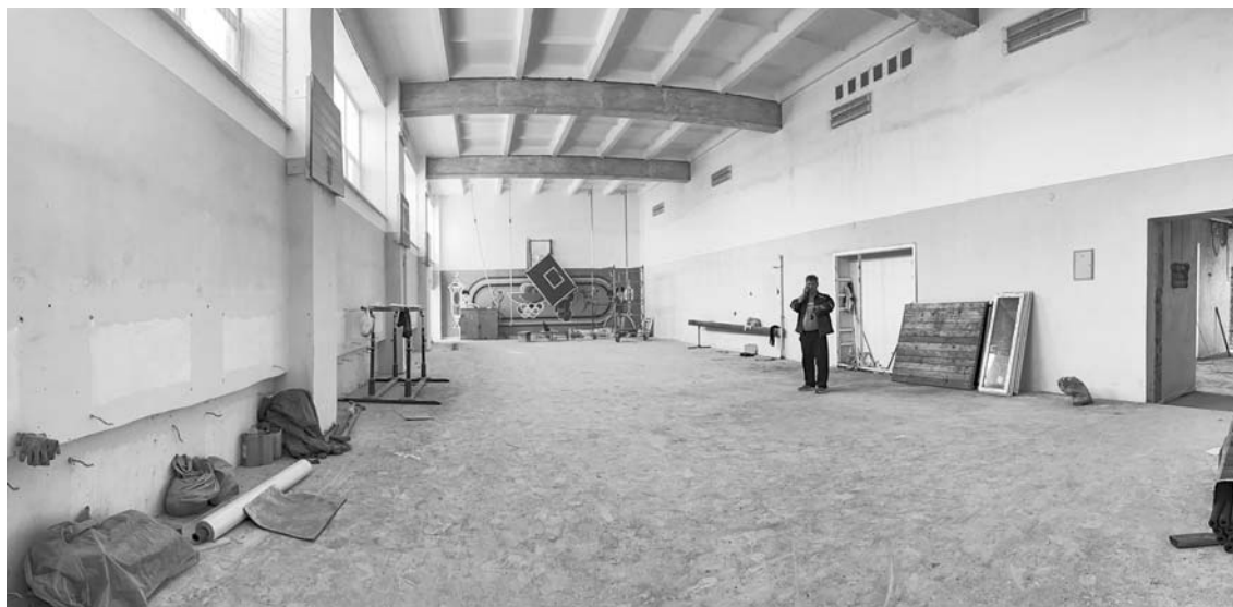
В спортивном зале шк. №11 идет подготовка к ремонтным работам / ФОТО ОЛЬГИ ПЕСТРЯКОВОЙ
