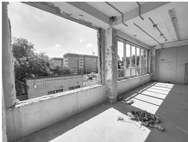
Подготов- ка оконных проемов к установке пластико- вых окон в шк. №17
