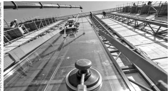
Уникальные стеклопакеты монтируют в павильоне № 20 «Химическая промышленность» на ВДНХ.
