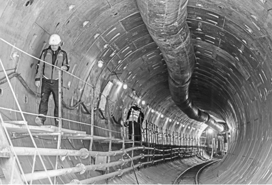
Левый тоннель, где задействован проходческий комплекс «Полина», пробит уже на 150 метров.
