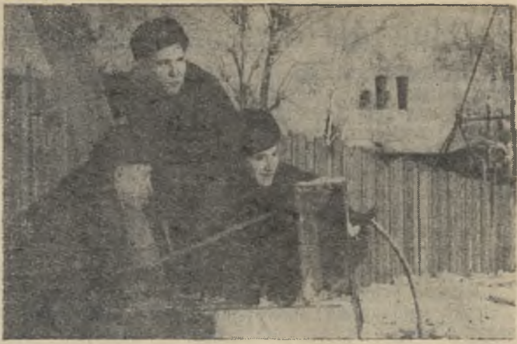
Идет строительство городской плотины. На снимке (слева направо): строители А. А. Смирнягин, В. С. Гладких, В. П. Терезман.
