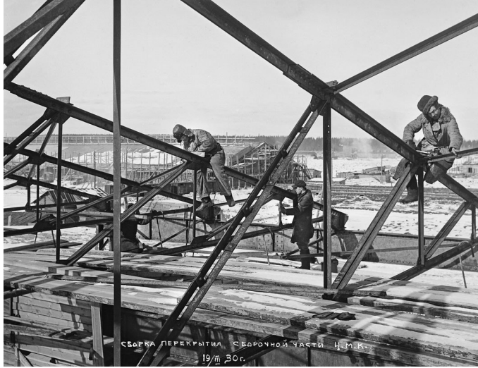
Сборка перекрытия цеха металлостроения Уралмашзавода. 1930-й год.
