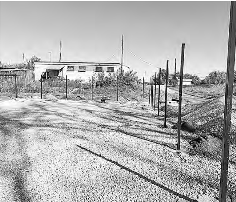
Строительство спортплощадки у местного Дома культуры / ФОТО ДМИТРИЯ КАРМАНОВА
