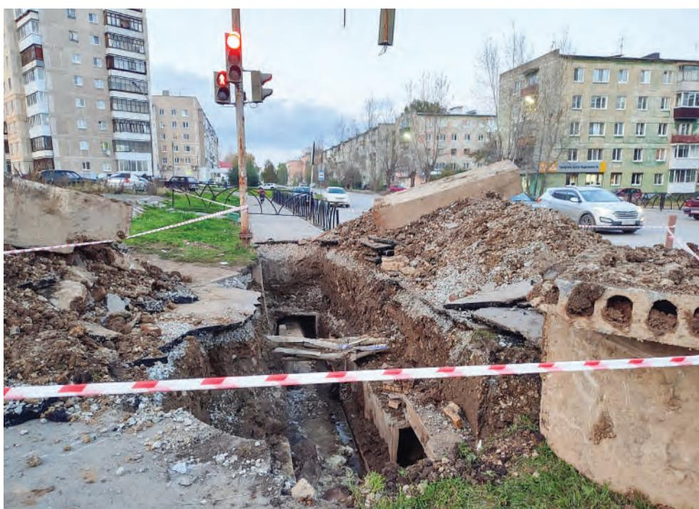
Порыв на теплосети в районе улиц К. Маркса – принято решение устраниить не при помощи установки хомута, а полностью заменить участок трубы
