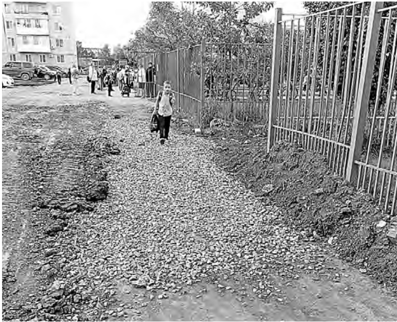
Засыпанная щебнем дорожка возле школы №17
