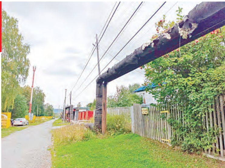
Трубы в некоторых местах неизолированные, они могут перемерзнуть
