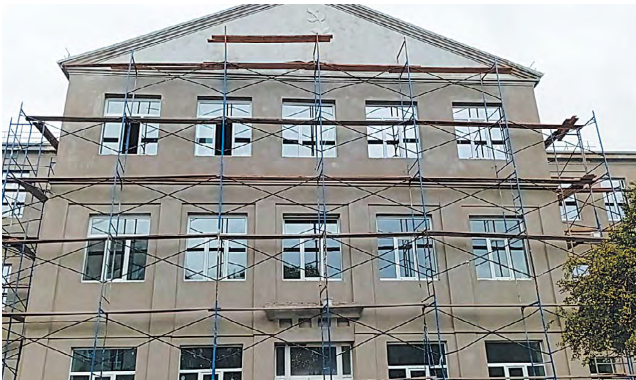
Школа №7. Наружные отделочные работы
