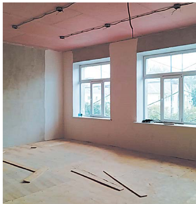
Школа №7. Внутренние отделочные работы
