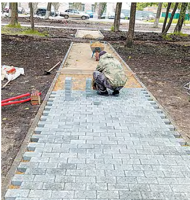
Укладка тротуарной плитки / ФОТО ДМИТРИЯ КАРМАНОВА
