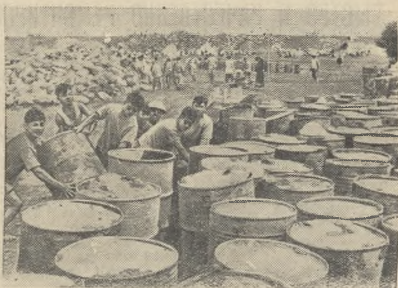
Демократическая Республика Вьетнам. Июль—август—это сезон дождей. В этом году идут особенно сильные дожди. В десяти километрах севернее Ханоя бурные воды разрушили часть дамбы канала Рапиде, соединенного с Красной рекой. Огромному району угрожало стихийное бедствие. Тысячи крестьян и рабочих вступили в борьбу с наводнением. Используя мешки с землей, бочки, камни и другие материалы, они заделали брешь и тем самым спасли урожай и имущество жителей окрестных городов и деревень. На снимке: подготовка железных бочек для закладки в тело дамбы. Фото Вьетнамского информационного агентства.
