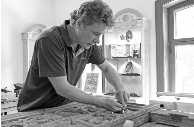
Святослав Шитов с отцом обновляют наличники, используя аутентичную фурнитуру, кованые гвозди.
