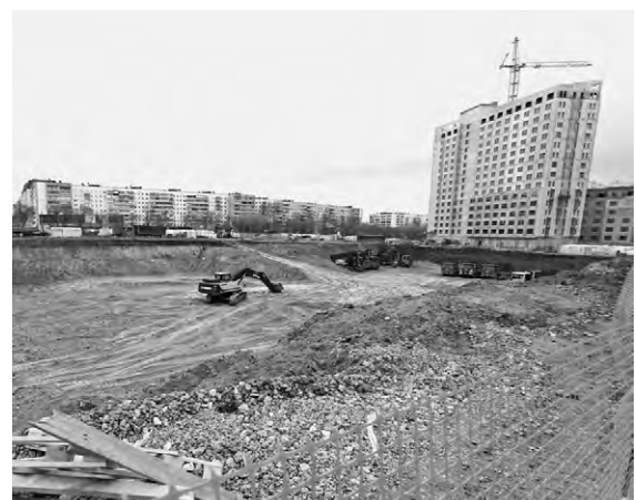
На площадке будущего кампуса идет разработка котлована, забивка свай, подготовка к бетонированию оснований учебного корпуса и многофункционального комплекса.
