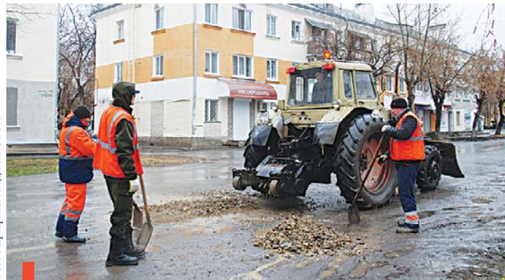
МУП «Горкомхоз» очищает обочины от накопившегося за зиму посыпного материала и готовит дороги к ямочному ремонту
