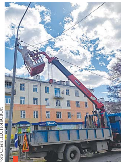
В МУП «Горэлектросети» для покраски опор освещения привлекли спецтехнику. Автовышка позволяет дотянуться до самого верха уличных светильников
