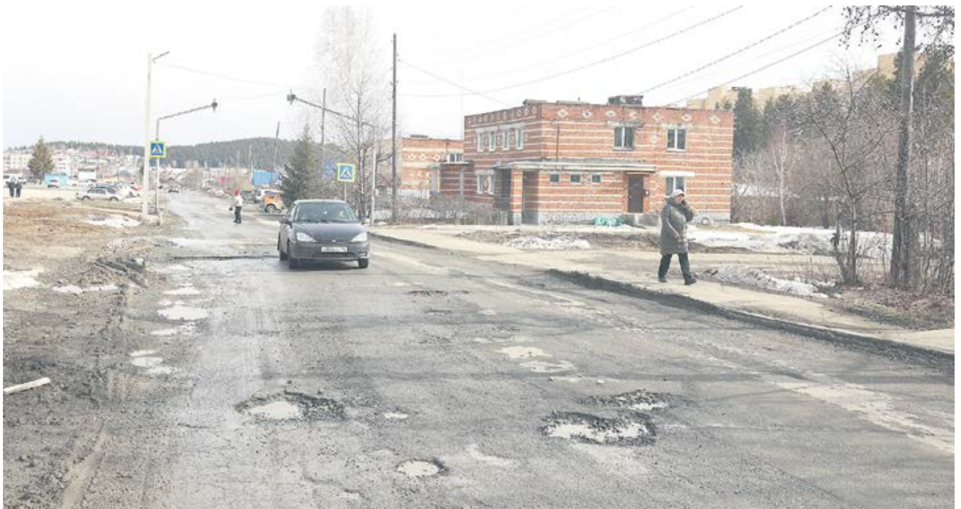
Улица Мичурина — одна из самых разбитых в городе. И давно нуждается в полноценном, а не ямочном ремонте. // Фото Владимира Коцюбы-Белых
