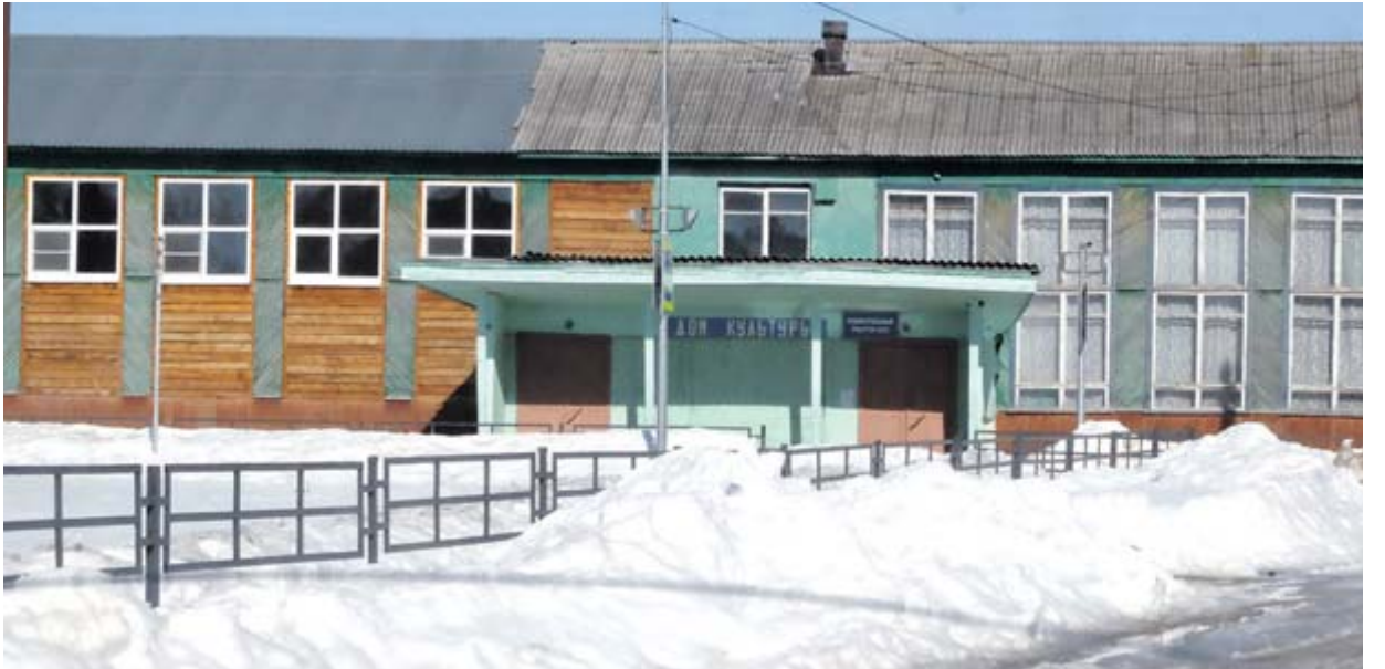
В концертном зале дома культуры находится школьный спортзал (крыша над ним отремонтирована). Остальная часть здания без ремонта. Третий год завклубом Алёна Черемисина работает одна без культорганизатора
