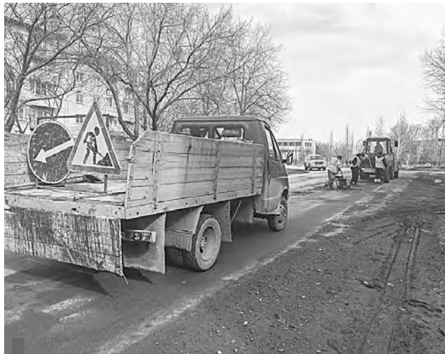
Техника и работники МУП «Горкомхоз» проводят временный ямочный ремонт на ул. Пушкинской
