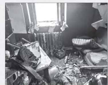
Назначена пожарно-техническая экспертиза.
