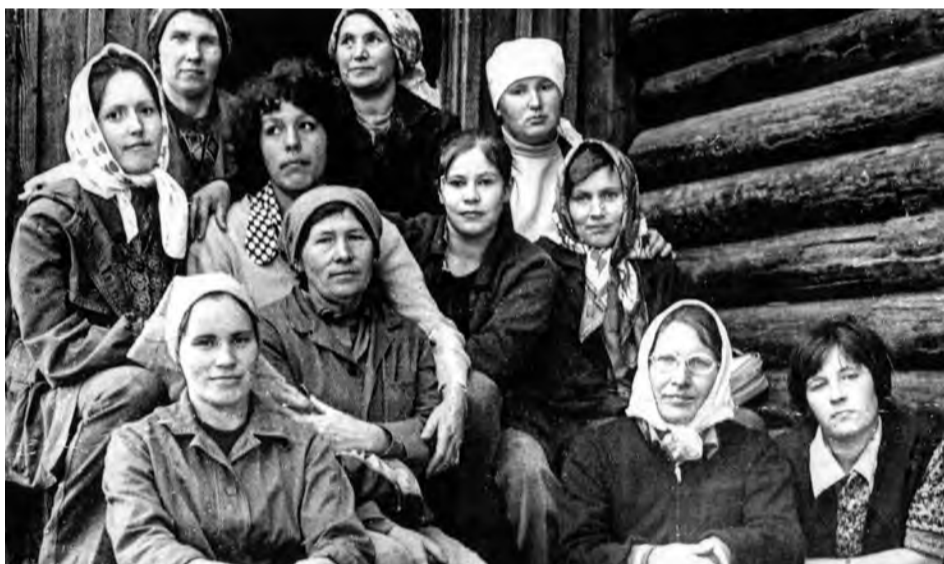
Бригада штукатуров, 1980-е годы
