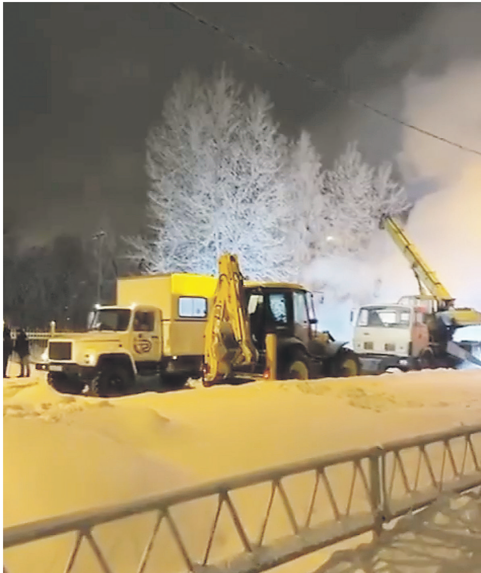
На устранении аварии работало много техники.
