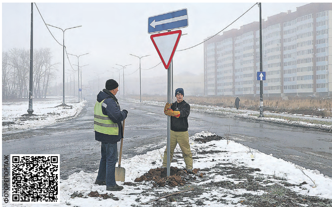
Установка новых дорожных знаков на дублере шоссе.
