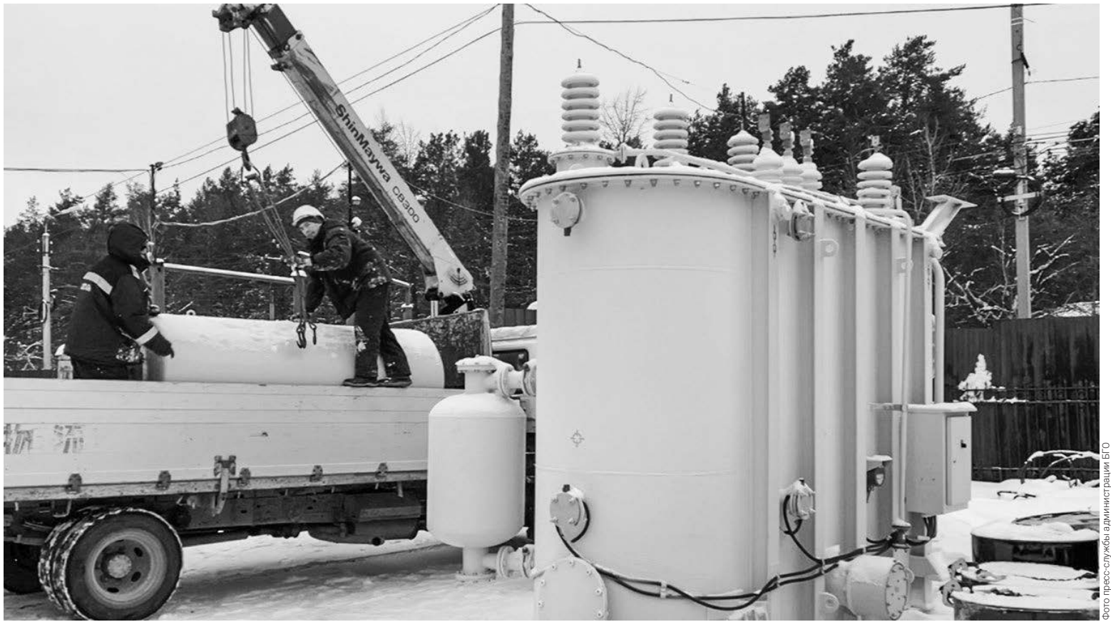
26 декабря новый силовой трансформатор уехал с базы «Уральских электрических сетей» на подстанцию «Южную». Агрегат мощностью 16 000 кВА заменит своего предшественника, мощность которого была в 2,5 раза меньше. Запустить трансформатор планируется этой весной. Его работа позволит улучшить качество энергоснабжения потребителей.
