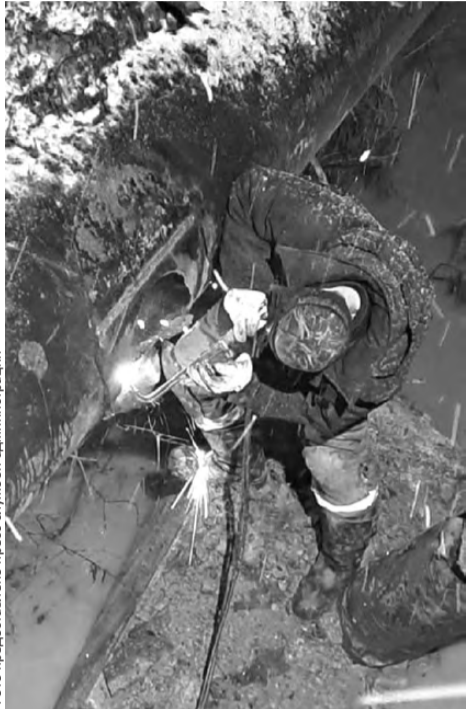
За работой – бригада «Водоканала»
