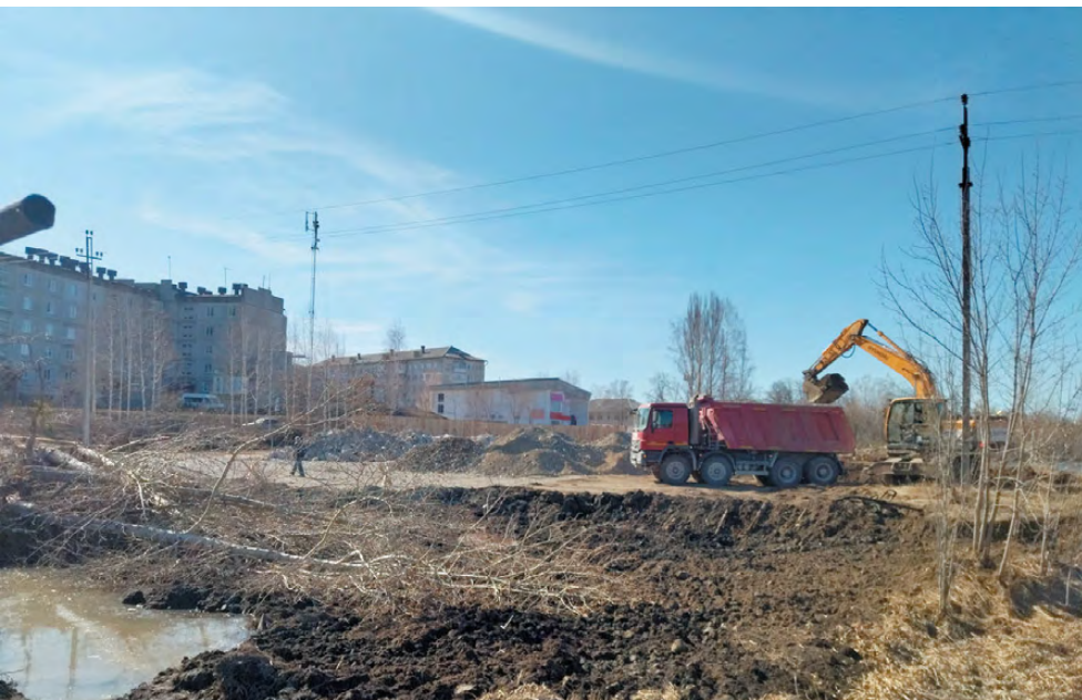
Сейчас в парке ведется планирование территории, вывозится грунт.
