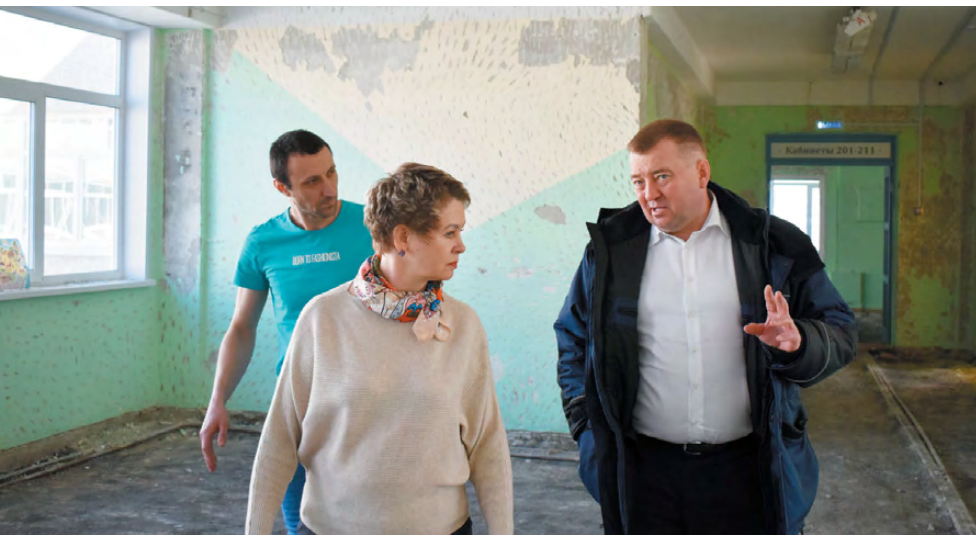
В помещениях ведутся демонтажные работы. Глава РГО обсудил с директорами школ продвижение ремонта.
