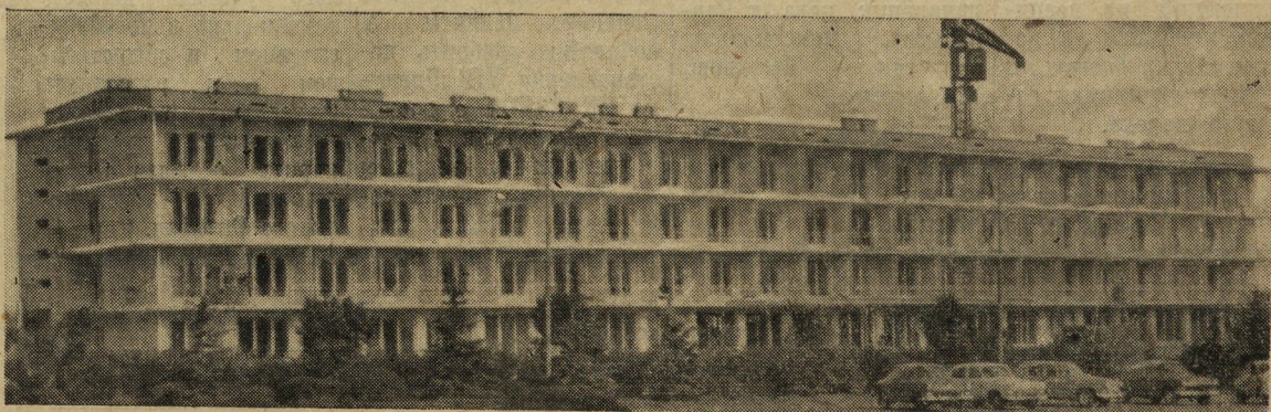
В Тбилиском аэропорту построено новое здание гостиницы
