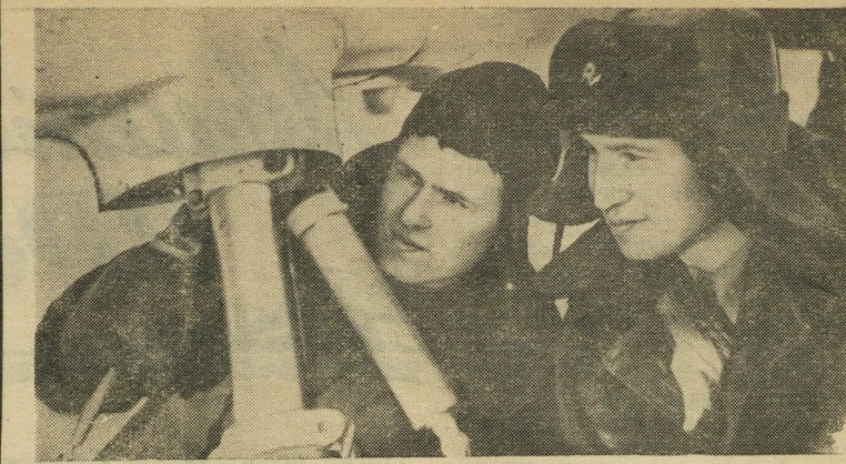
Старший авиатехник по эксплуатации Г. П. Ратушный и исполняющий обязанности старшего инженера Салехардского подразделения Х. А. Сайтов осматривают узлы шасси самолета Ан-2. Фото пилота Д. Палина.
