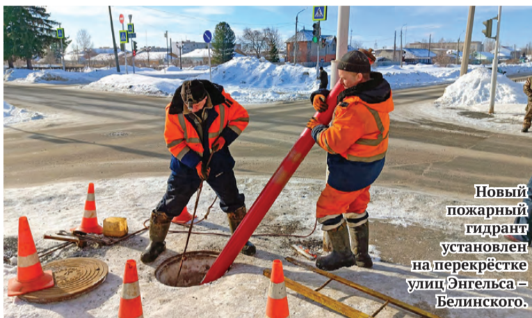
Переулок между улицами Карла Либкнехта и Тельмана. Работы начались. Мастер ремонтного участка Егор Лачимов и экскаваторщик Роман Вахонин.
