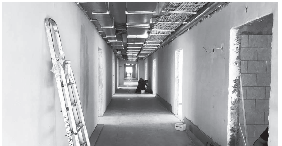
Идет ремонт в буланашской поликлиники / Фото: пресс-служба АЦРБ
