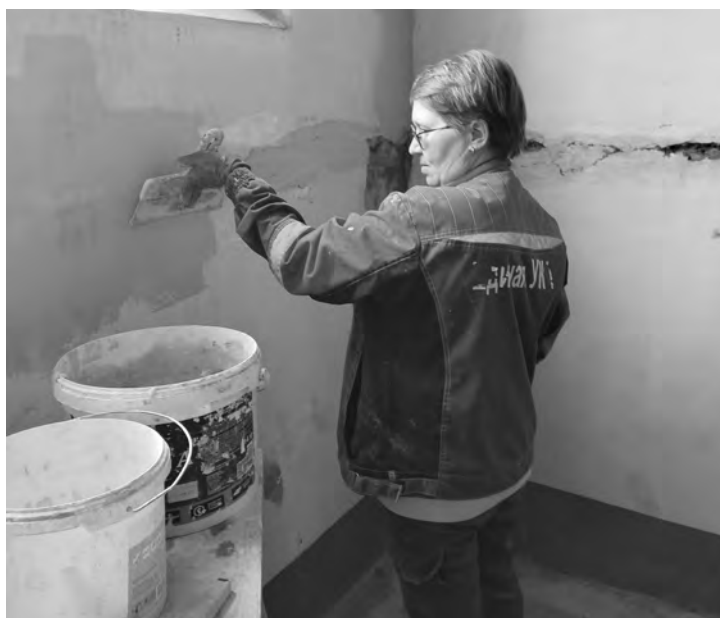
Косметический ремонт подъезда в доме № 8 по ул. Луначарского в Талице.
