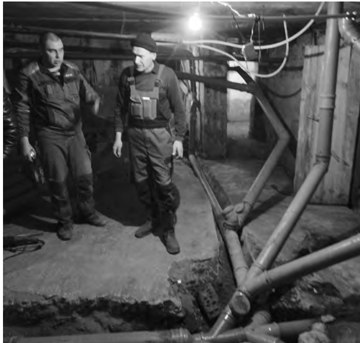
Капремонт коммуникаций в подвале дома № 1 по ул. Калинина в Талице.
