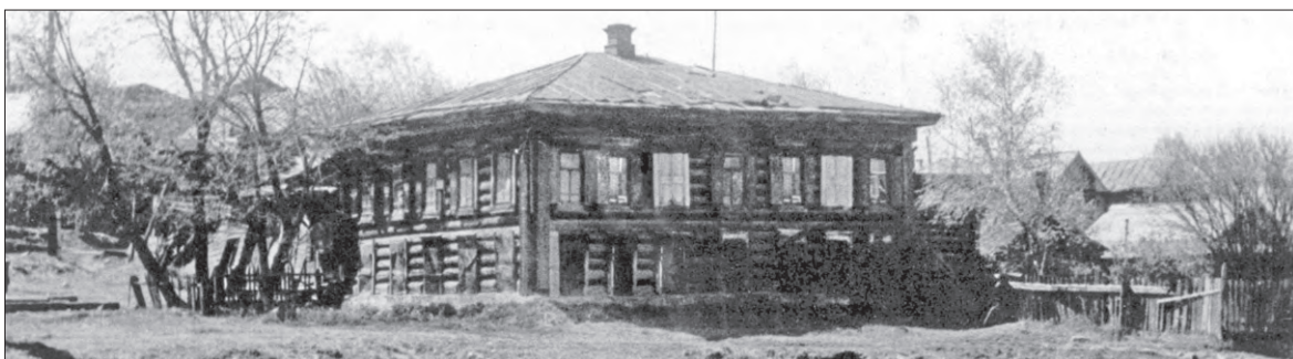
Ул. Металлистов. Дом смотрителя плотины.
