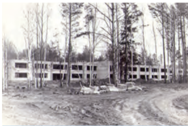
Строительство спального корпуса. 1989 год
