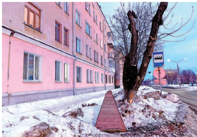
Сотрудники РИРа постоянно контролируют состояние источников наземного пожаротушения.
