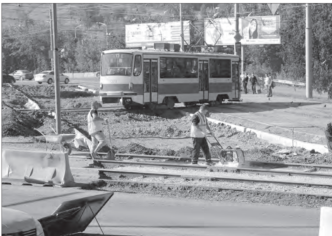
Работы не мешают движению трамваев.
