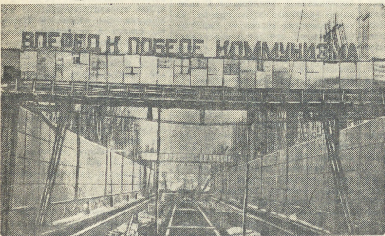
Первый пусковой объект Куйбышевского гидроузла — двухкамерные судоводные шлюзы — вступил в строй весной 1955 года. Сейчас на шлюзах идет монтаж гигантских створок рабочих ворот, установка закладных частей и механизмов управления, укладка бетона и монтаж арматуры на самых верхних ярусах.
