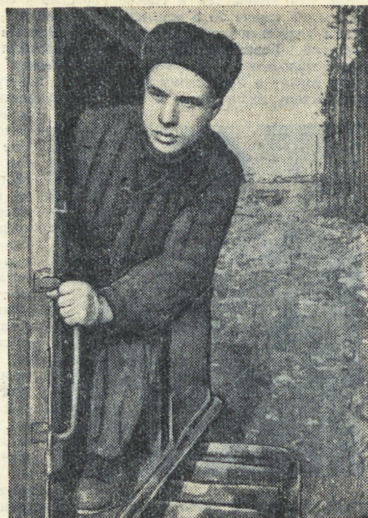
Молодой бульдозерист Сергей ЕНДЕРОВ, работающий на планировке площадки под главный цех завода железобетонных изделий и подземной шоссеиной дороги, систематически выполняет сменные задания.
