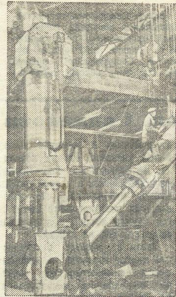
Сборка гидравлической системы механизма шагания экскаватора «ЭШ-20/65».
